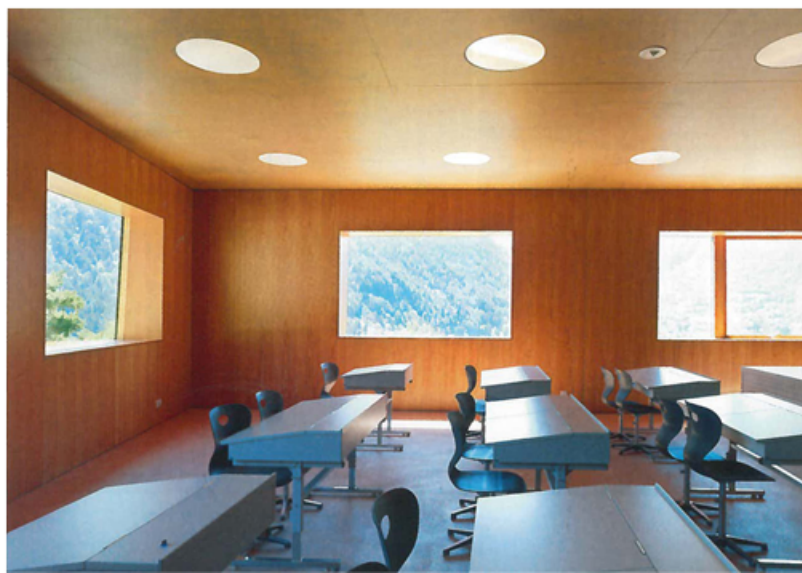
Übereck orientiertes Klassenzimmer mit Lärchenholz-Auskleidung
