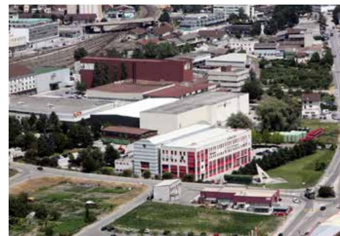
Vue du quartier avant transformation
