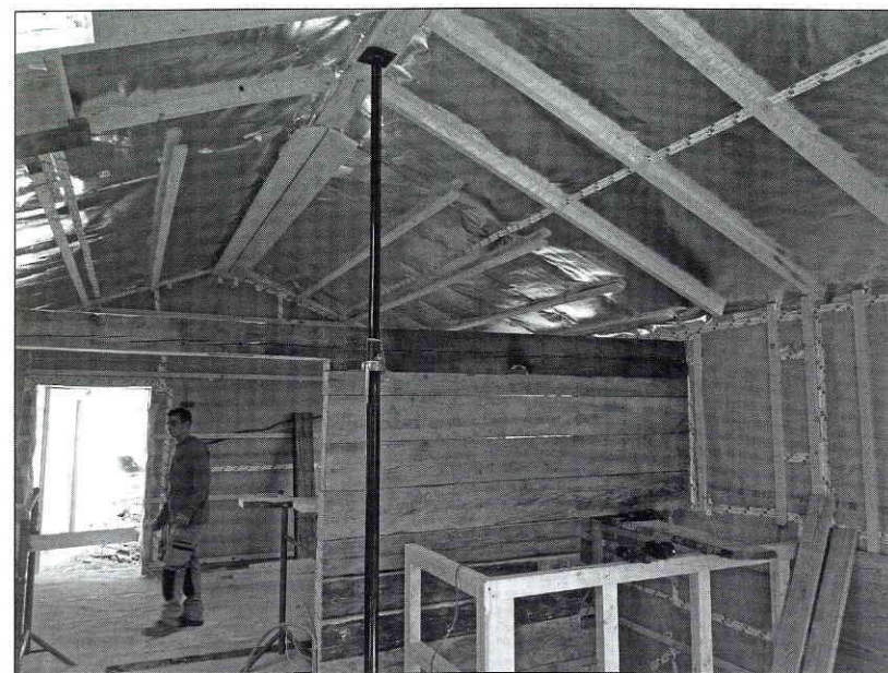
Ici le volume est entièrement isolé de l'intérieur. L'ancienne paroi de madrier réhabilitée sépare le séjour de la cuisine.
