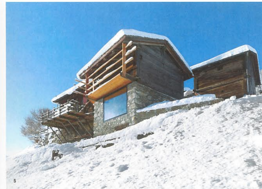
5 — Ein anderes Projekt von Savioz Fabrizzi war 2012 das ehemalige Maiensäss im Entremont-Tal. Als Teil einer kleinen Gruppe dramatisch am Abhang stehen- der Häuser für den Viehbetrieb wurde die Maison Boisset mit ihren fassadenbündigen neuen Fenstern zum Ferienhaus mit großartigem Talblick.
