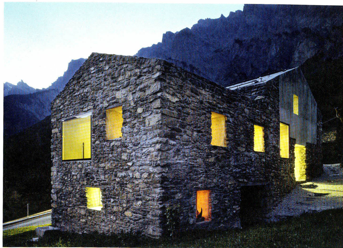
Zusätzliche Fensterflächen durchbrechen die geschlossene Bruchsteinfassade und lockern das äußere Erscheinungsbild auf. Ihre flächenbündige Verglasung macht sie als „neues“ Element ablesbar und bildet nutzbare Nischen im Innern.
